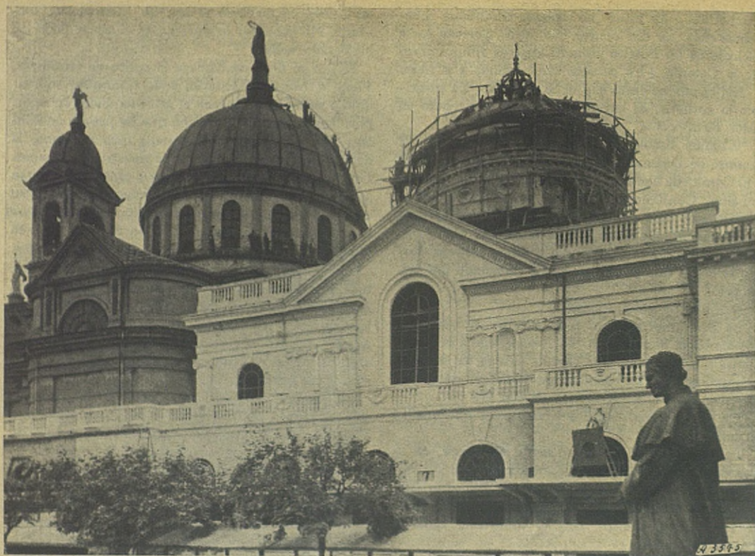
Las obras de la Basilica van recibiendo los últimos toques en su parte exterior.
